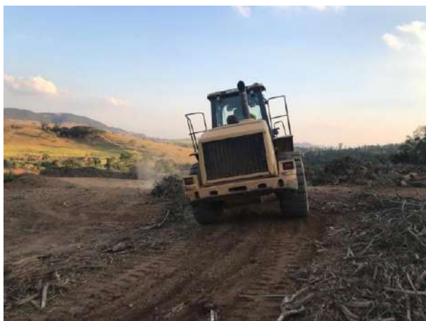
Foto 37 – Pá carregadeira concha realizando a atividade de limpeza do local de enleiramento 01 (Registro fotográfico 25/05/2021).
