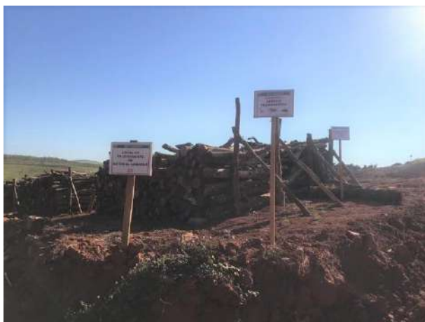
Foto 39 – Placas de sinalização local de enleiramento 03 (Registro fotográfico 28/05/2021).
