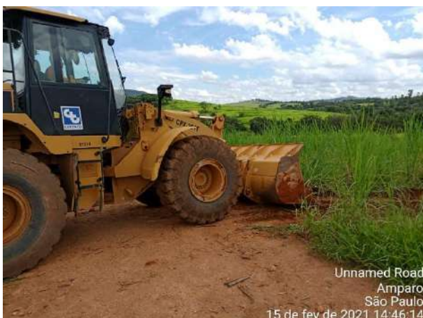
Foto 1 – Limpeza do local de enleiramento 1 (15/02/2021).
