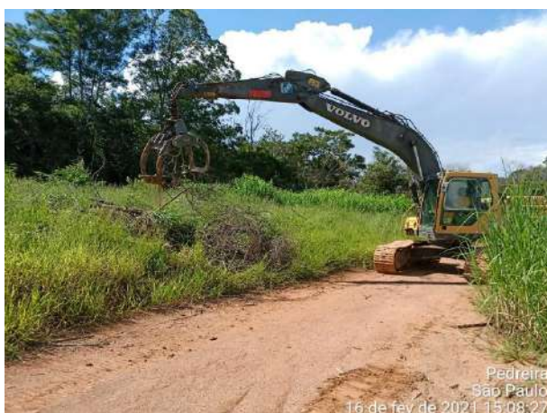
Foto 5 – Escavadeira Pinça na atividade de separação dos produtos florestais (16/02/2021).
