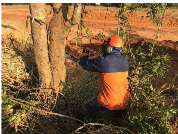
Foto 23 – Atividade de derrubadas de árvores (Registro fotográfico 15/05/2021).
