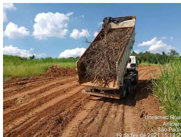
Foto 6 – Descarregamento do material lenhoso (19/02/2021).
