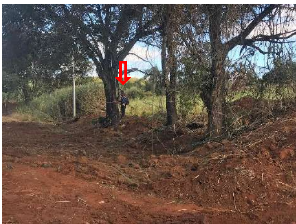
Foto 17 – Colaborador realizando a remarcação das árvores (Registro fotográfico 12/05/2021).
