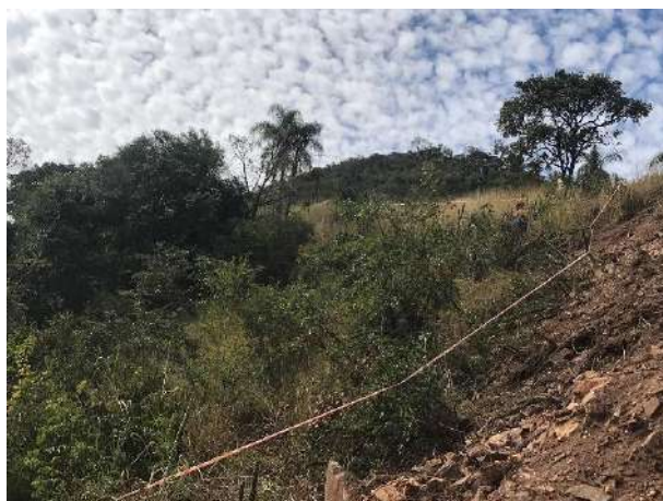
Foto 18 – Fita zebraada delimitando a área a ser suprimida (Registro fotográfico 12/05/2021).
