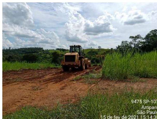
Foto 4 – Limpeza do local de enleiramento 1(15/02/2021).
