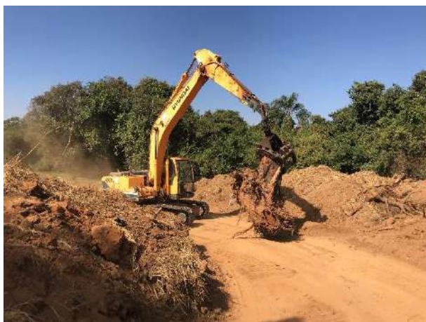
Foto 29 – Escavadeira garra realizando a organização de raízes (Registro fotográfico 19/05/2021).
